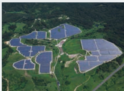
エコパワーJPを設立し、再生可能エネルギー事業に参入(釧路音別太陽光発電所)
